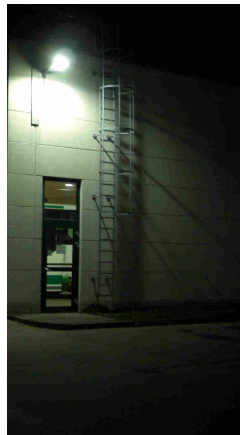
modernisierte Außenleuchte mit 40 W Induktions-Leuchtmittel Gesamtverbrauch je 40 W
