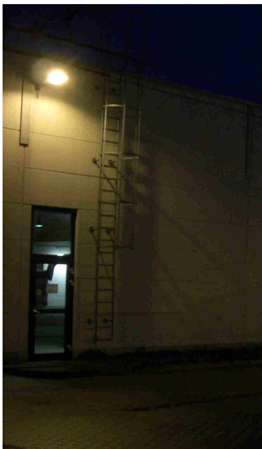
alte Außenleuchte mit 100 W NAV-Leuchtmittel Gesamtverbrauch je 112,5 W
